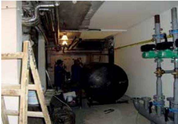
Demontaža prezračevalnih kanalov
